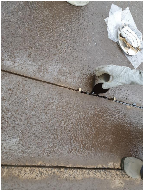
Figur13. Kabel RG178 i spår som sedan fylls igen med bitumen 50/70.
