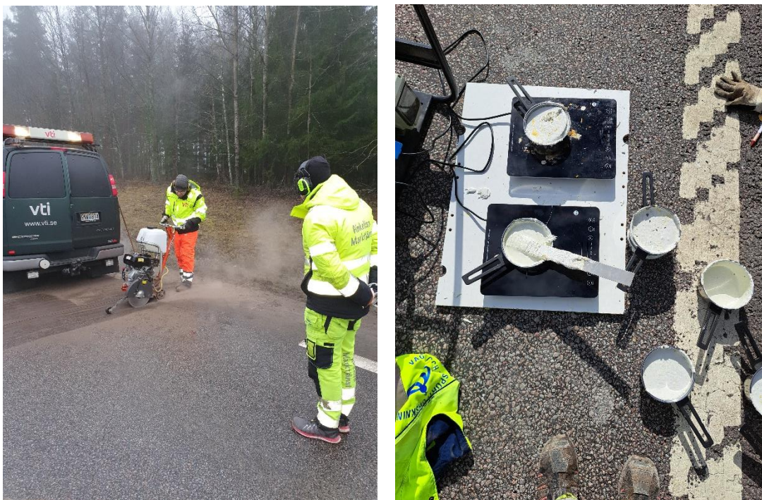
Figur 31. Till vänster: spårsågning. Till höger: upphettning av termoplast till 180C.
