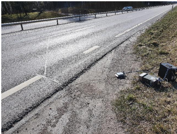
Figur14. Slutresultat efter montering.
