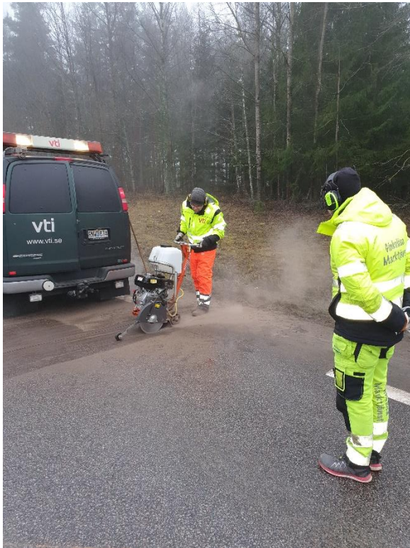
Figur 12. 20 mm djupt spår sågas.
