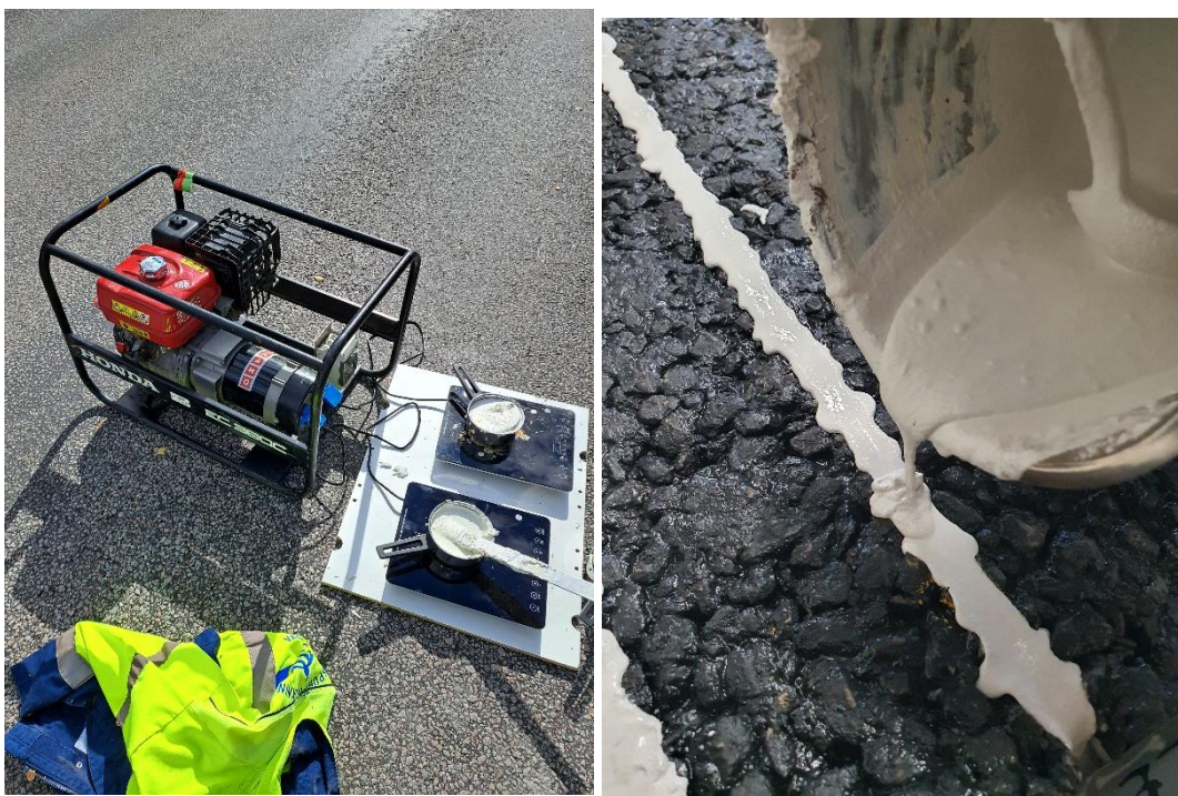
Figur 32. Till vänster: 230 V generator. Till höger: fyllning av frässpår.
