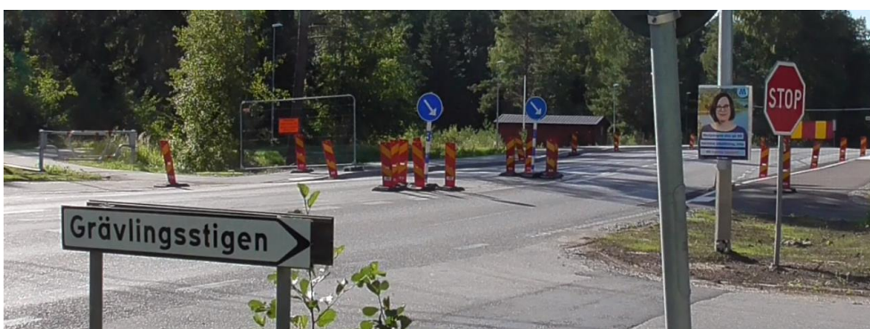
Figur 5.4 Gångpassage Grävlingstigen med mittrefug och pågående vägarbete.
