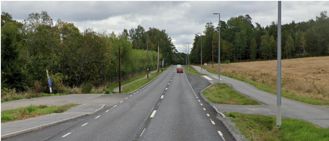
Figur 3.2 Enkel gångpassage, Nacka (Google Maps, 2020).
