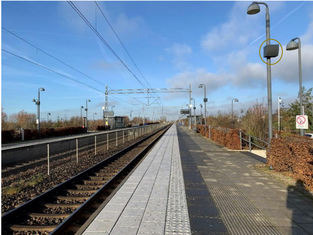
Figur 7 Högtalare på västra Ingelstad station placerade i lyktstolpar, plattformsförbindelse i form av trappa till höger.
