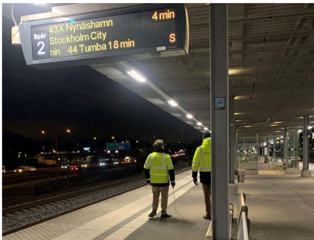
Figur 3 Plattformskylt med vita högtalare monterad längst till vänster. Öppet väderskydd utan dörrar i förgrunden, en möbleringszon med pelare och bänkar.
