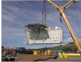
LASS: Boendemodul på offshore-plattform i komposit.
