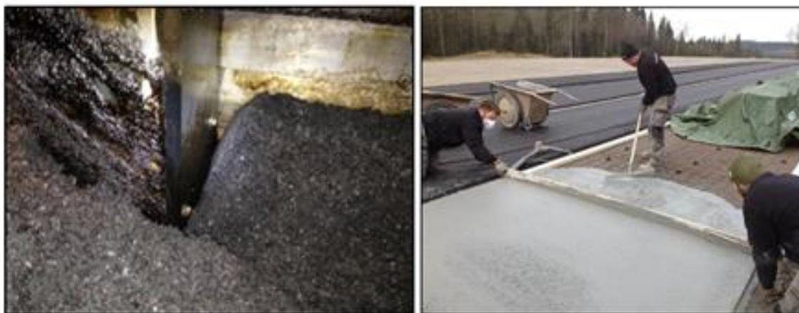
Figur 1.2. Asfaltblandning av gummi (vänster), gjutbetonggjutning (höger) [13] (Licens förvärvat via Copyright Clearance Center).
