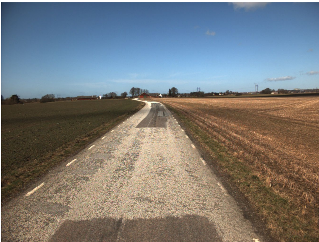
Figur 29 Exempel på sträcka där LCMS och subjektiv bedömning indikerar mycket stensläpp. En bild 25 m in i sträckans huvudriktning på väg M887. Foto: Automatiskt taget från mätbil.
