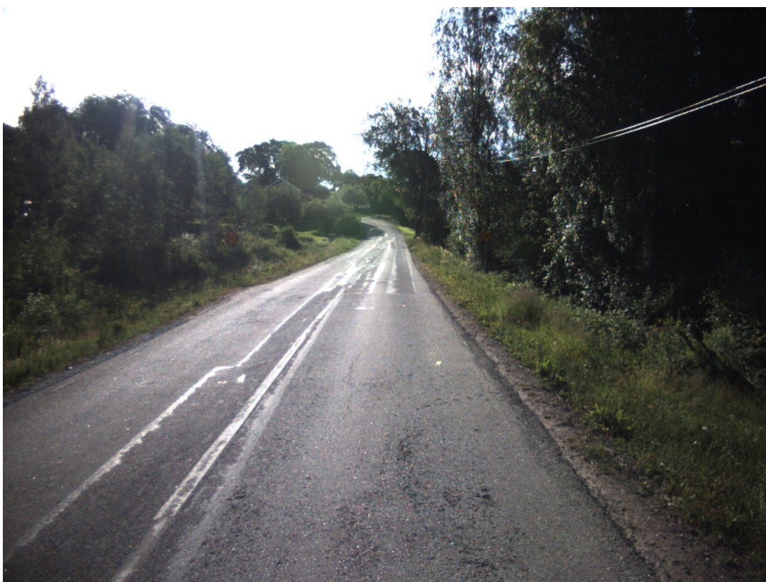
Figur 30 Exempel på sträcka där subjektiv bedömning indikerar på mycket stensläpp men enbart måttlig förekomst enligt LCMS-systemet. En bild 135 m in i sträckans motriktning på väg W908. Foto: Automatiskt taget från mätbil.
