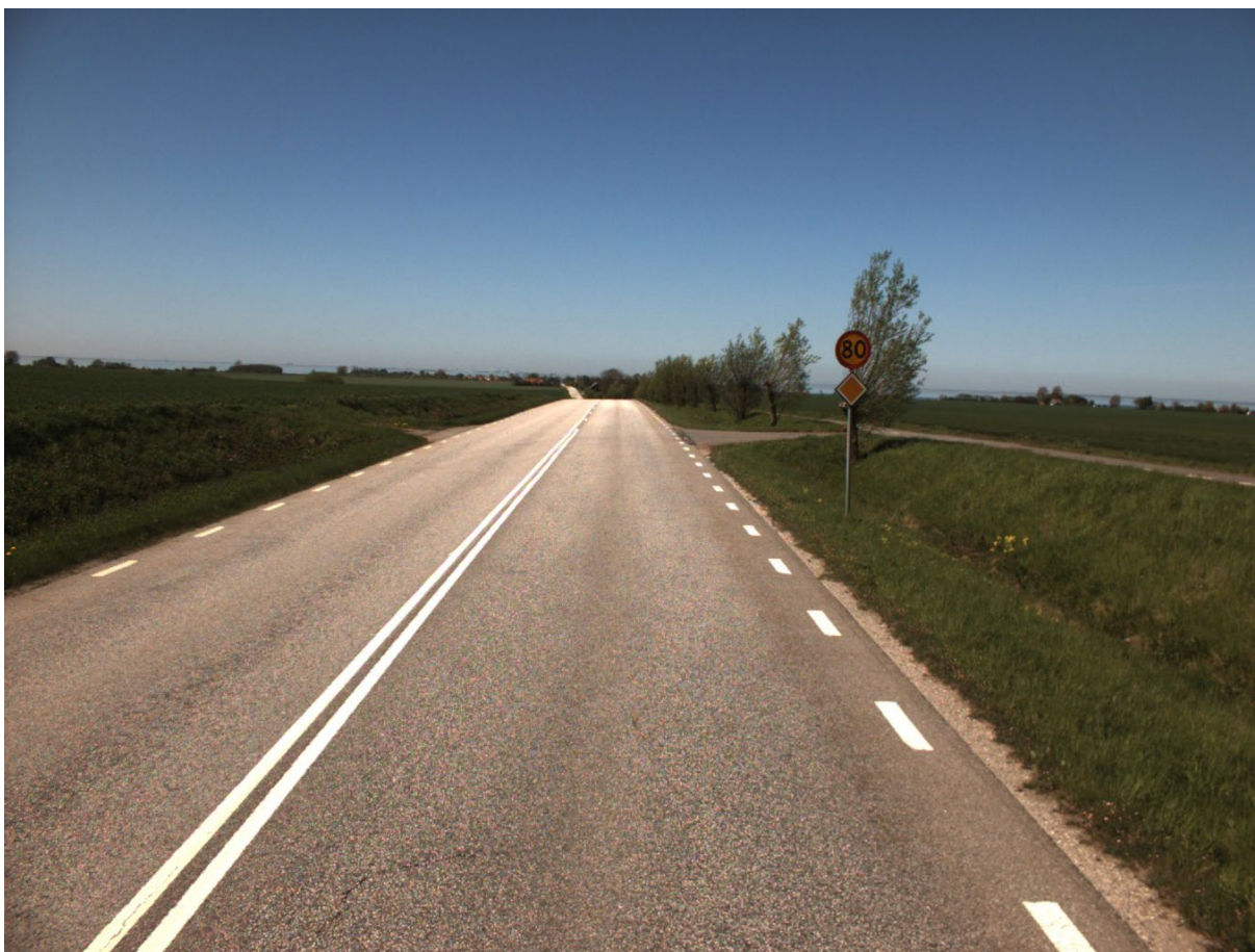
Figur 31 Exempel på sträcka där subjektiv bedömning indikerar på låg förekomst av stensläpp men relativt stor från LCMS-systemet. En bild 2 435 m in i sträckans huvudriktning på väg M1136. Foto: Automatiskt taget från mätbil.
