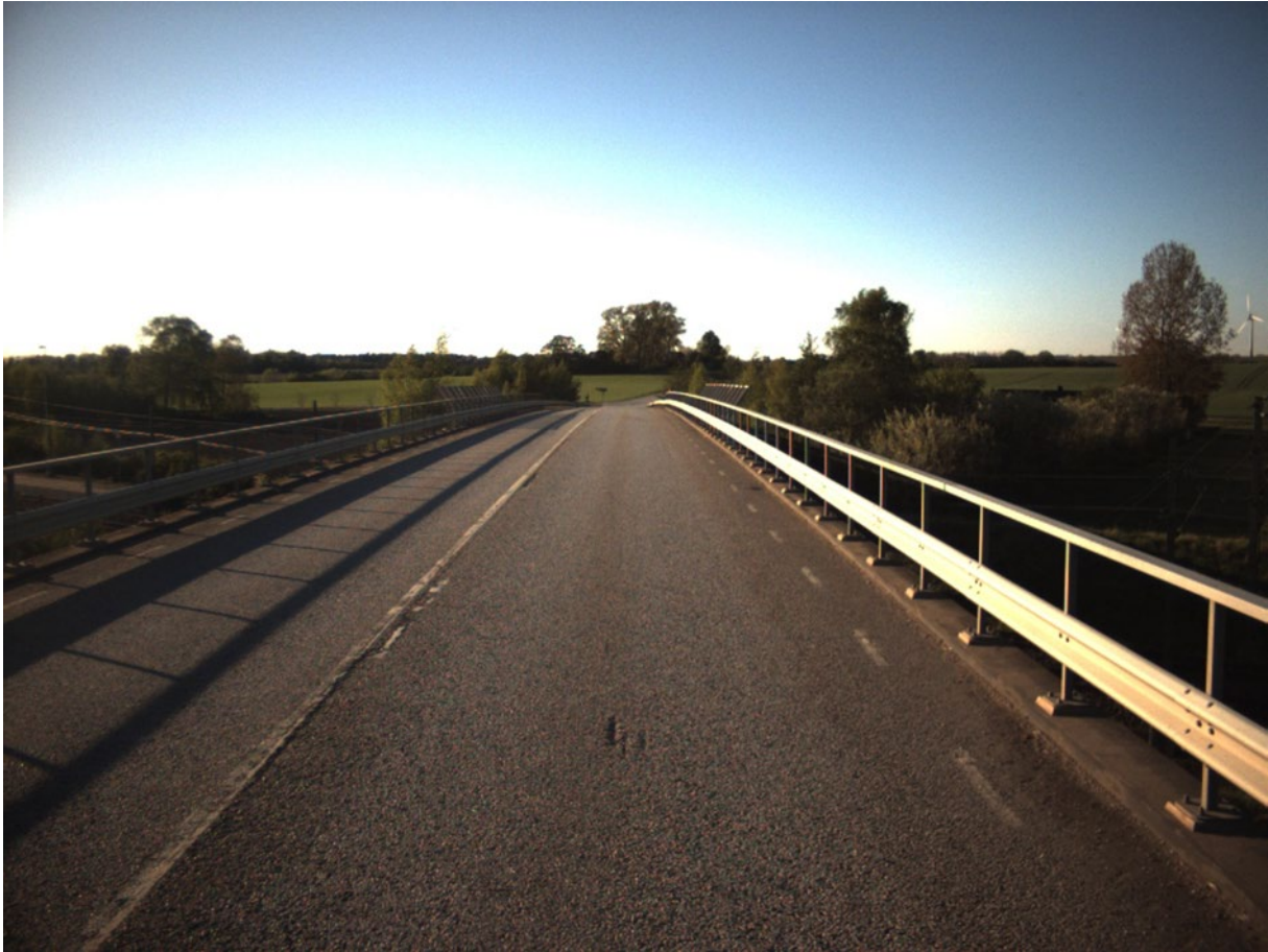
Figur 19 Väg 1179 i Skåne. Åldrad beläggning med stensläpp, ABS11. Foto: Automatiskt taget från mätbil.
