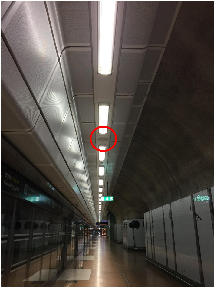
Figur 7. Röd cirkel visar på placering av infällda högtalare i undertaket. Märke: okänt
