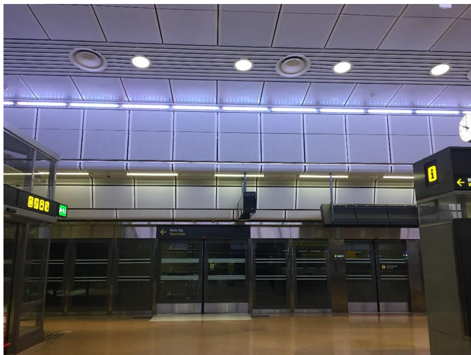
Figur 10. Bild över plattformsrummet. I taket sitter mikroperforerade kassetter
