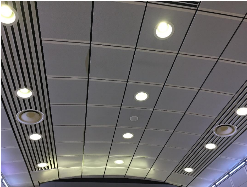
Figur 14. Närbild av taket som består av mikroperforerade kassetter
