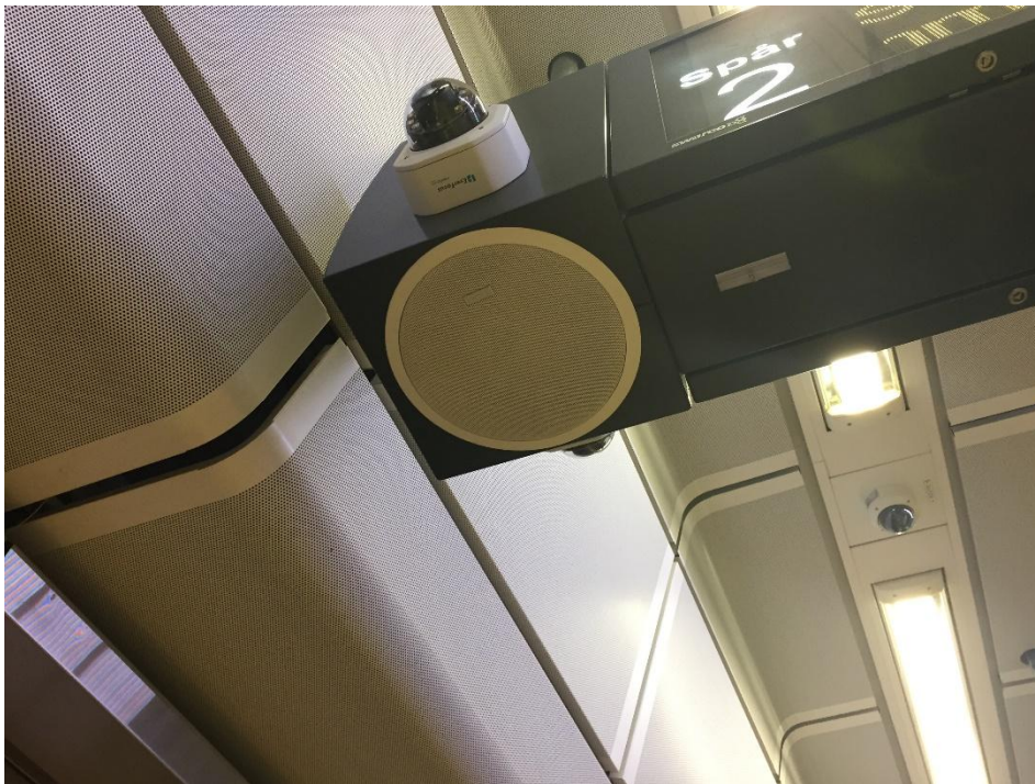
Figur 3. Högtalare infälld i dynamisk skylt. Märke: okänt
