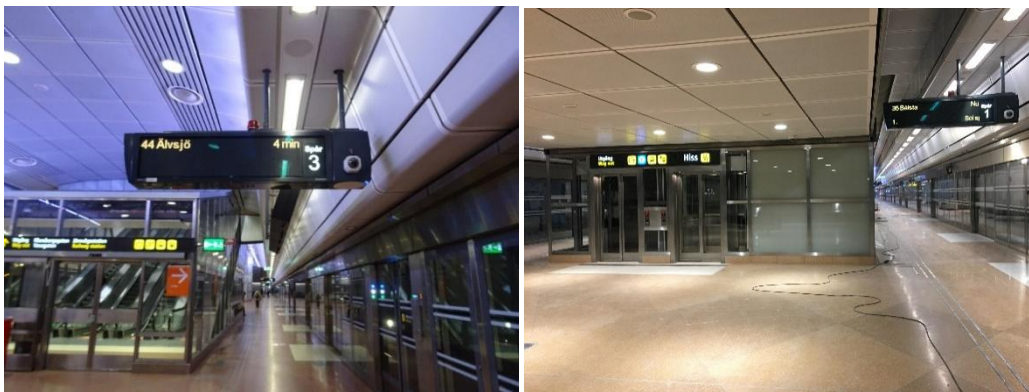
Figur 3. Plattformsskylt på Stockholm city, plattformsförbindelser hiss respektive inbyggd rulltrappa
