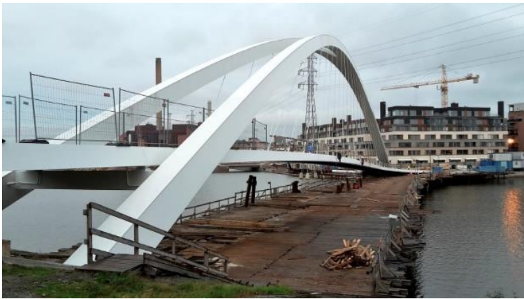
Bron Isoisänsilta under konstruktion. Foto: Kreate.fi.
