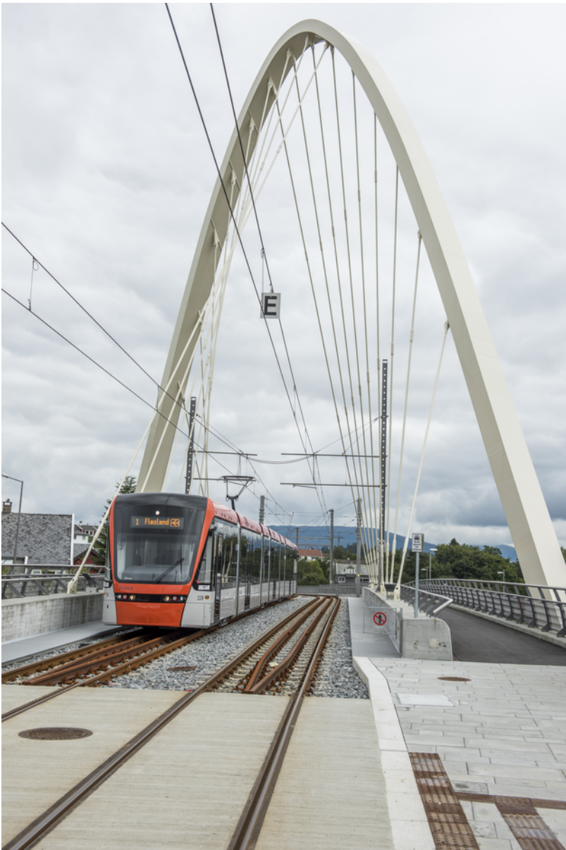
Bild 2.5.2. Bybanen i arkitektoniskt tilltalande bro över bilväg, Birkelandsskiftet i Bergen. Bild: Bybanen utbygging.
