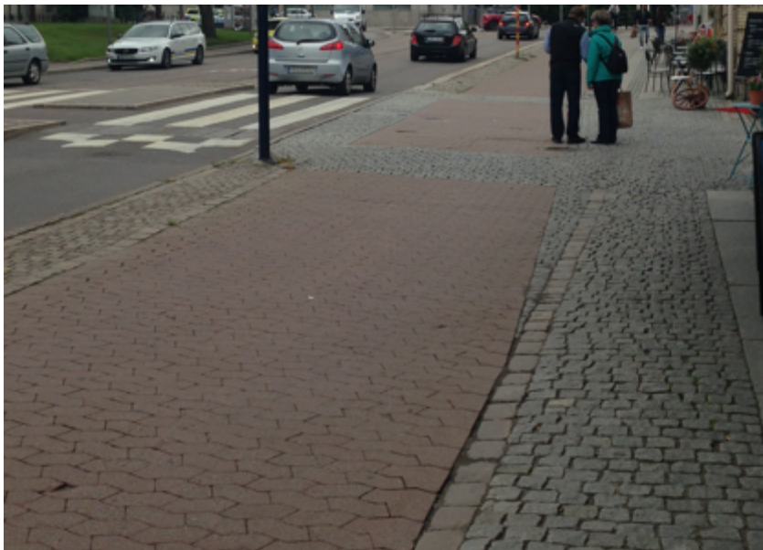
Figur 2:3 Utmynning av gångfartsområde, kantat av gatstensrader
