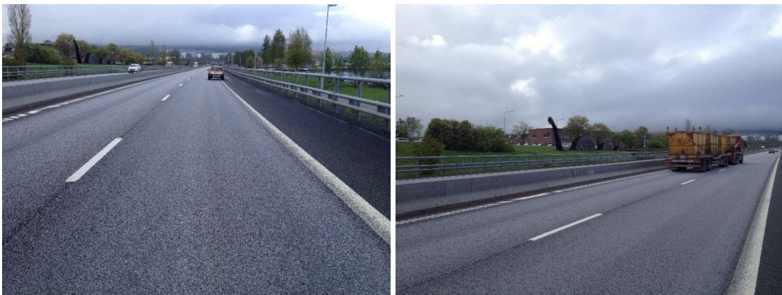
Bild 5. Referenssträcka 1 med ordinarie dränasfalt (2014).
