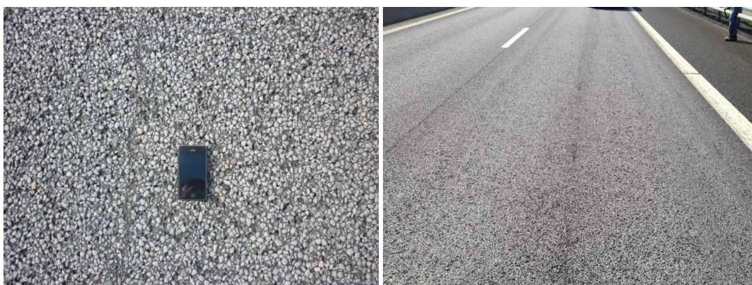
Bild 8. Referenssträcka 2 med ordinarie dränasfalt (vänster 2012, höger 2013).
