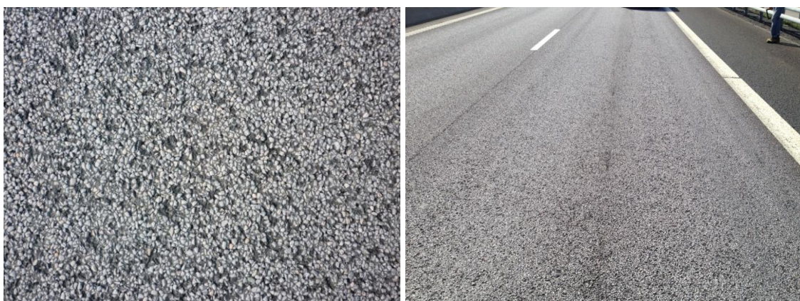
Bild 3. Referenssträcka 1 med ordinarie dränasfalt (vänster 2012, höger 2013).
