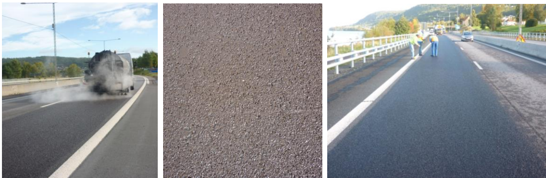
Bild 13. Försegling av dubbeldrän, E 4 Huskvarna, september 2010.
