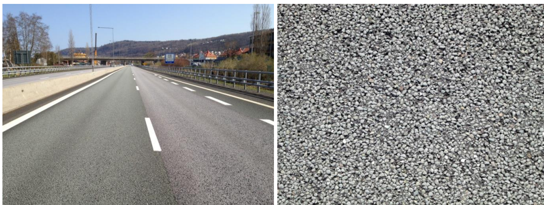
Bild 9. Referenssträcka 3 och 4 med ordinarie dränasfalt av ryolit (höger) och diabas (vänster, 2013). Bilden till höger visar diabas.
