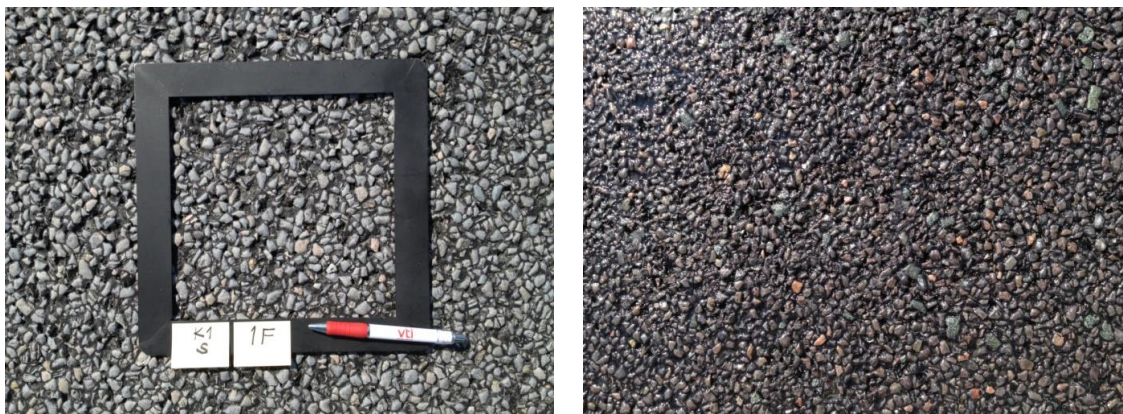
Bild 1. Provsträcka 3 med en försegling av Fog Seal (fuktig yta till höger, 2013).
