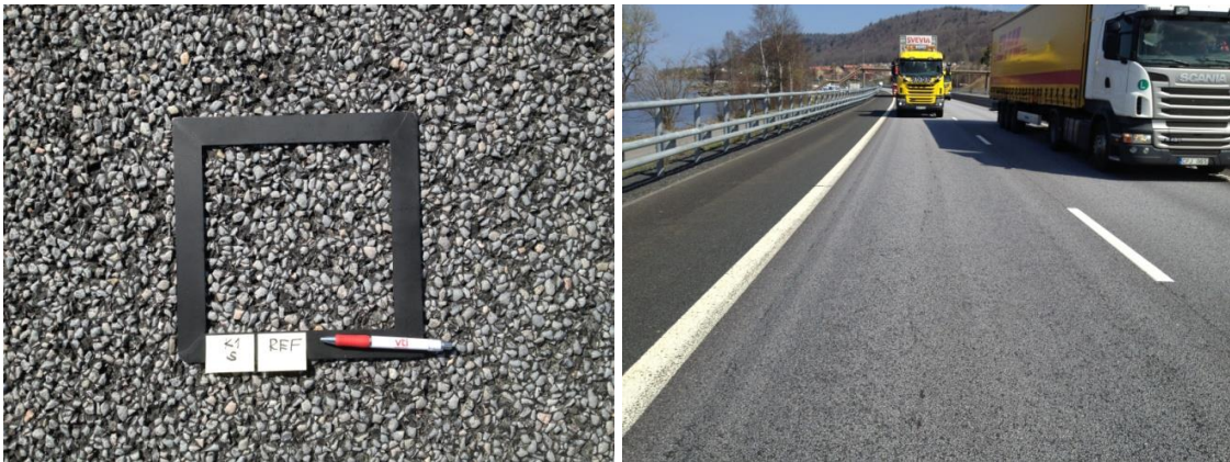
Bild 4. Referenssträcka 1 med ordinarie dränasfalt (2013).
