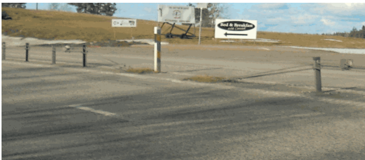
Bild 16: GC-passage av mötesseparerad väg – enkel öppning i räcket. Förstorad detalj av öppning.
