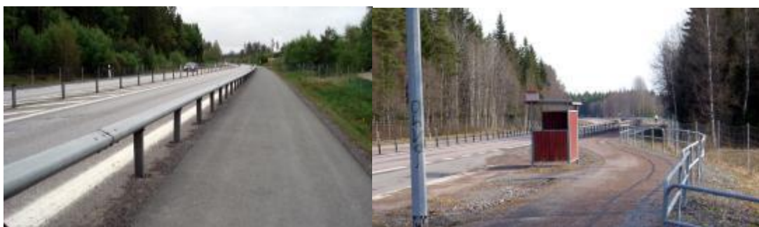
Bild 6. Cykelväg separerad med räcke, tv dubbelriktad GC-bana, th vid busshållplats. Obs att räcket till höger i högra bilden är skydd för en brant slänt.
