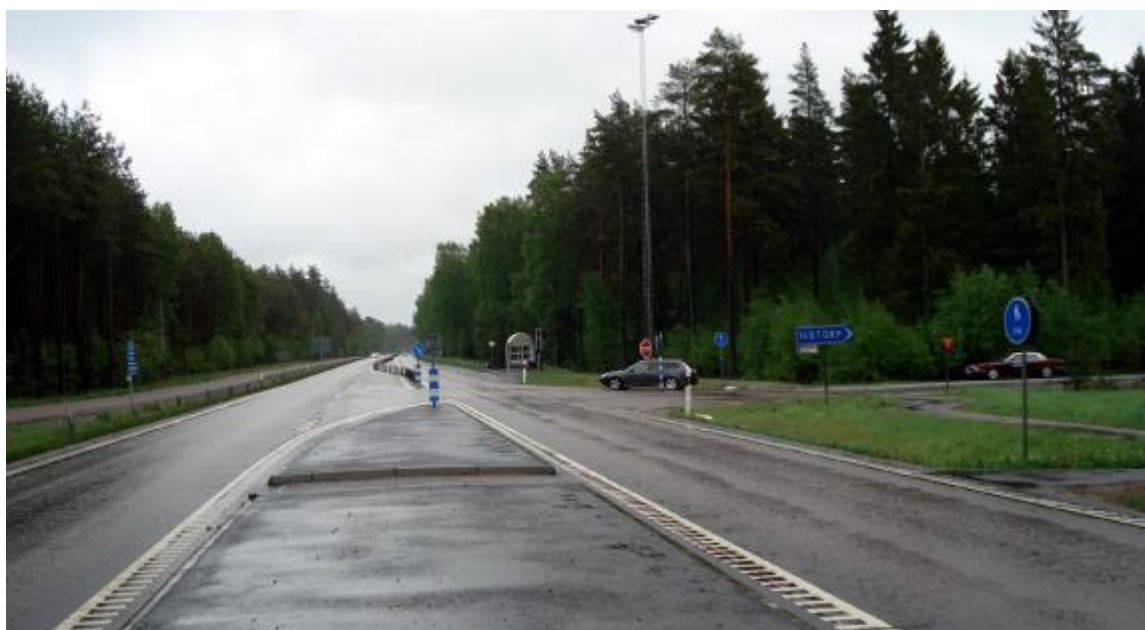
Bild 24: Passage av mötesseparerad väg – bred refug.
