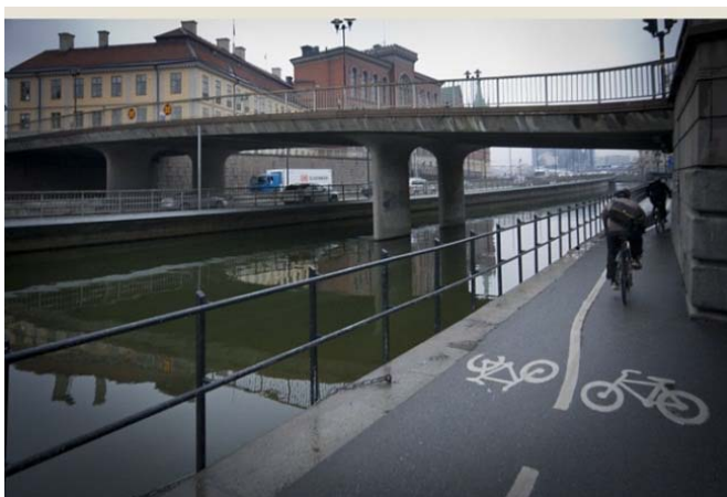
Figur 14. Brofundament (till höger i bild) vid Munkbron (mittsektion).
