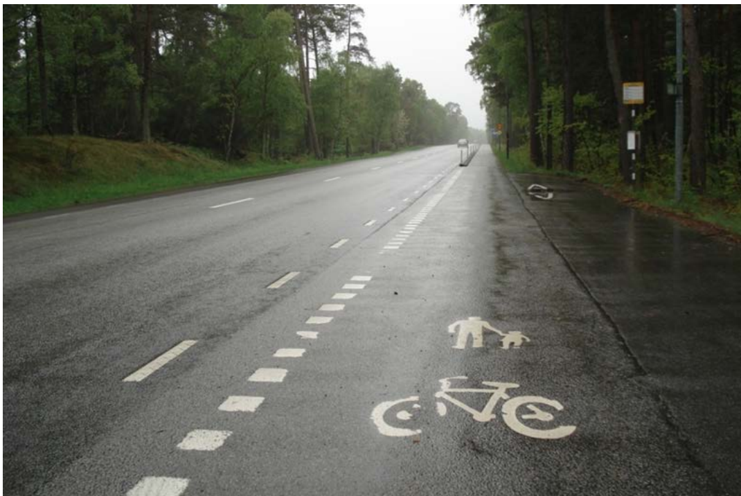
Figur 5 Målade gång- och cykelsymboler på cykelbanan längs väg 9 mellan Ystad och Nybrostrand. Foto: Jutta Pauna-Gren, Ramböll.
