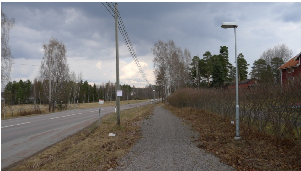
Figur 7 Grusad cykelväg längs väg 266 mellan Falun och Vika (Färnviken). Foto: Mikael Spjut, Ramböll.
