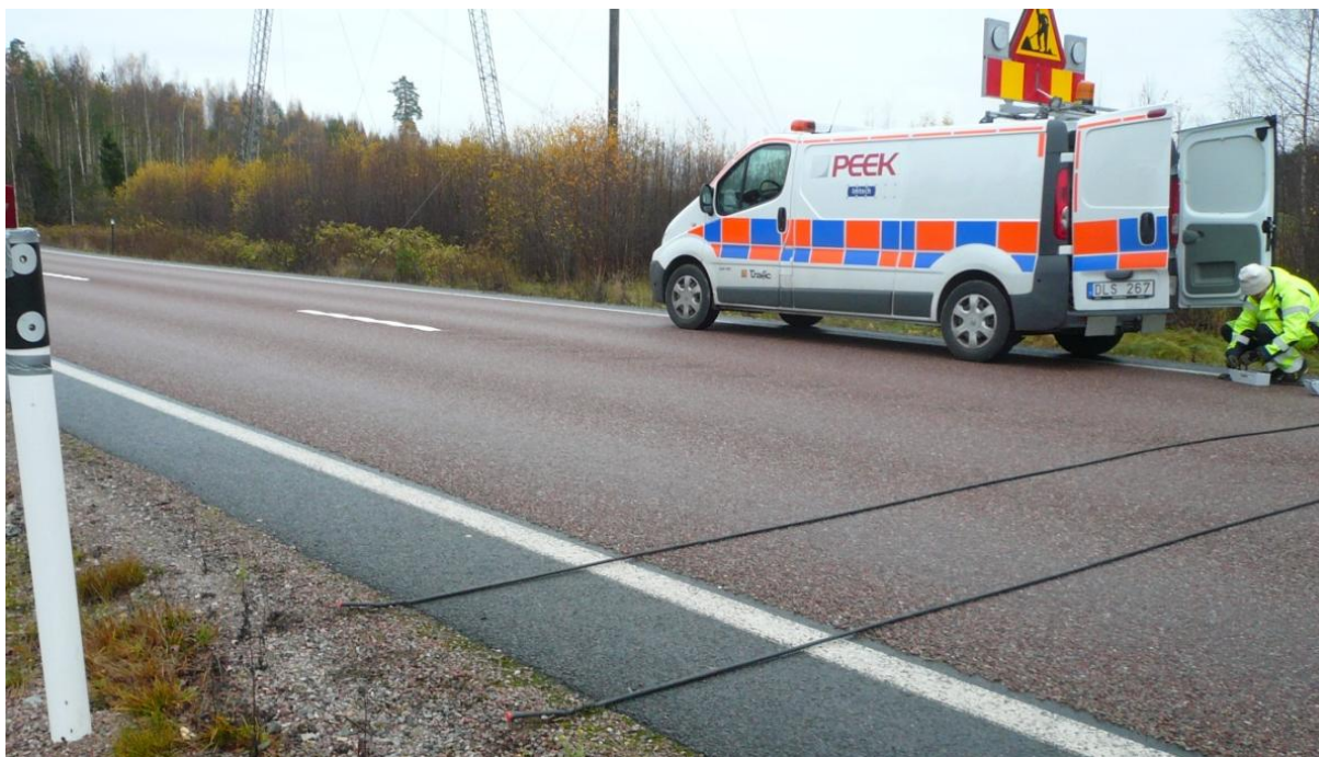
Figur 5 Installation av mätslangar vid mät punkt 2 (vid viltstolpe), Foto D. Björklöf
