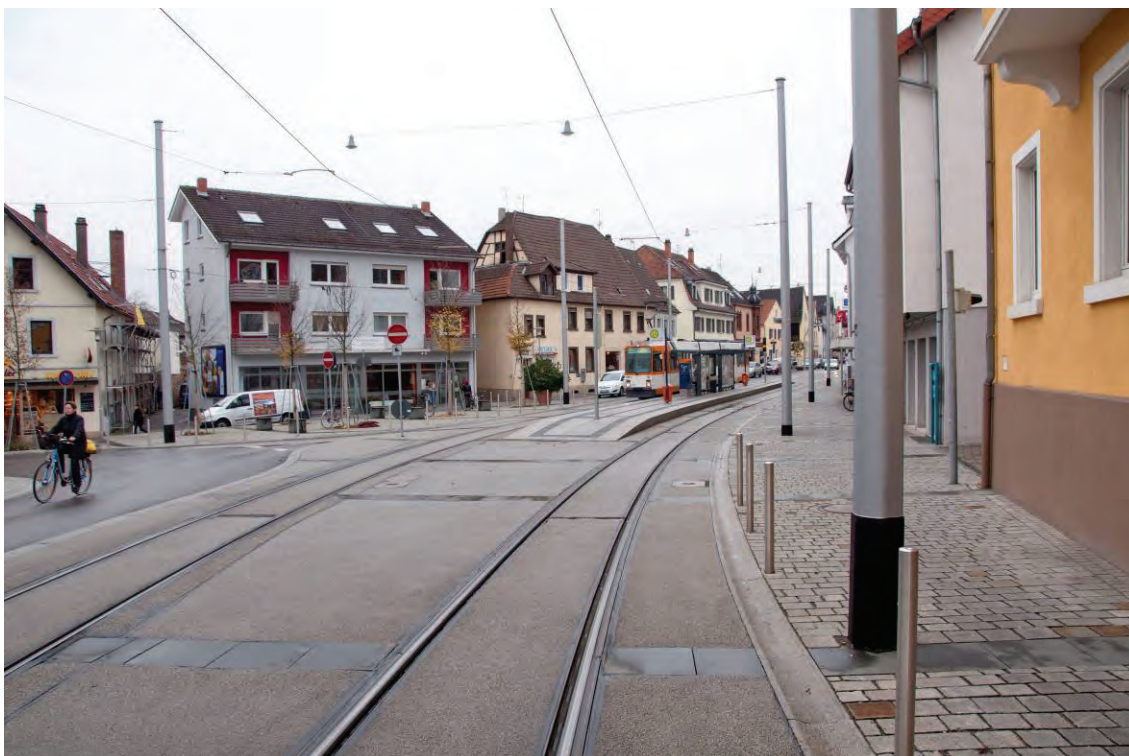
Figur 25 Nya linjen till Kirchheim har relativt obetydligt inslag av stadsmiljöförbättrande åtgärder. Undantag är Odenwaldplatz i centrala Kirchheim som har försetts med bl.a. mer påkostad markbeläggning och kontaktledning av klassisk spårvägmodell. (Foto: © TJ Kommunikation.)
