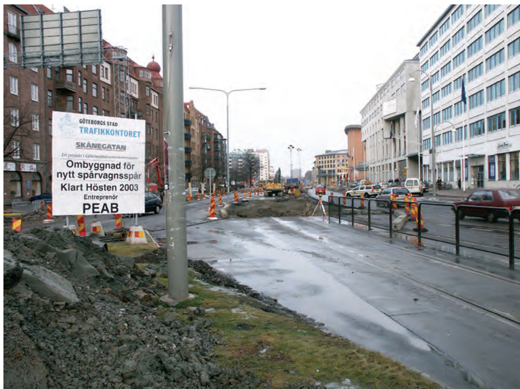
Figur 12 Spårvägsbyggnation under år 2003 på det s.k. Evenemangsstråket i Göteborg, mellan Korsvägen och Stampbroarna. Denna sträcka ingick i Kringen, Kollektivtrafikringen, som finansierades inom Göteborgsöverenskommelsen, Göken. (Foto: ©TJ Kommunikation.)
