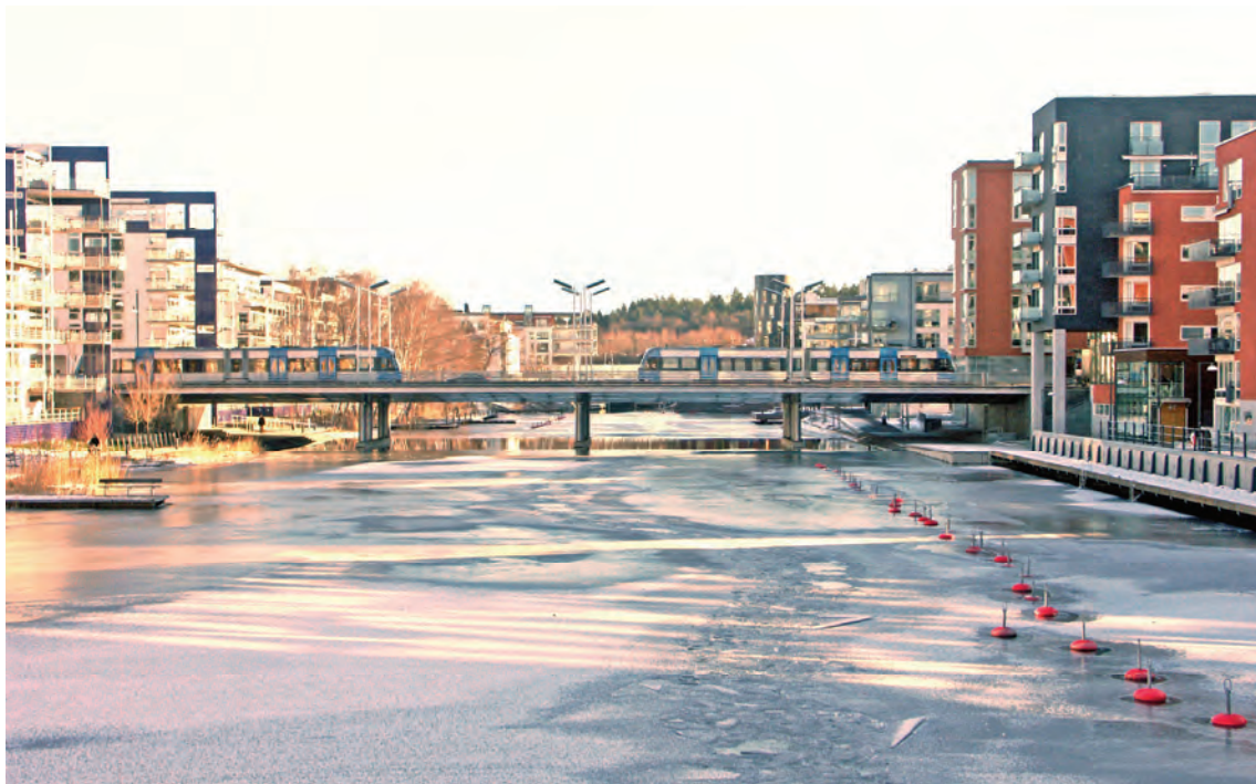
Figur 3 Två spårvagnar på Tvärbanan möts på bron över Sickla kanal i Hammarby sjöstad, som till största del byggdes upp när Tvärbanan redan var på plats, invigd sommaren 2002. (Foto: ©TJ Kommunikation.)
