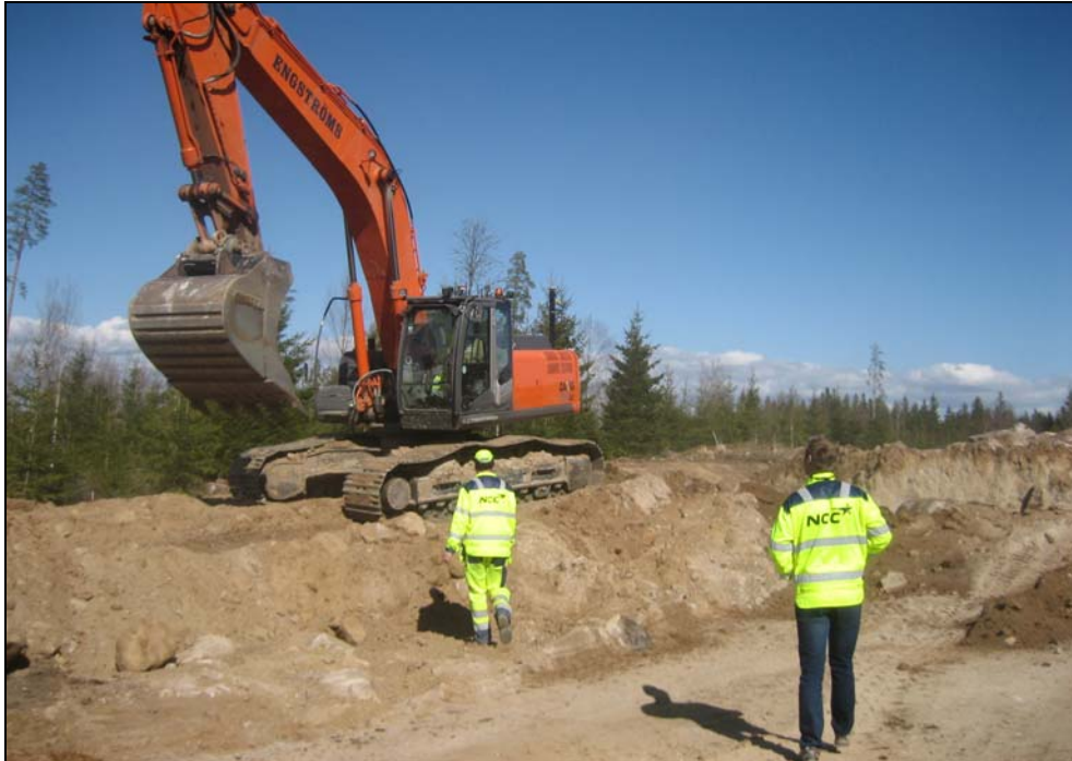
Bild 7. Produktion enligt utsättningsdata (I denna anläggningsmaskin användes en ytmodell upprättad med InRoads)
