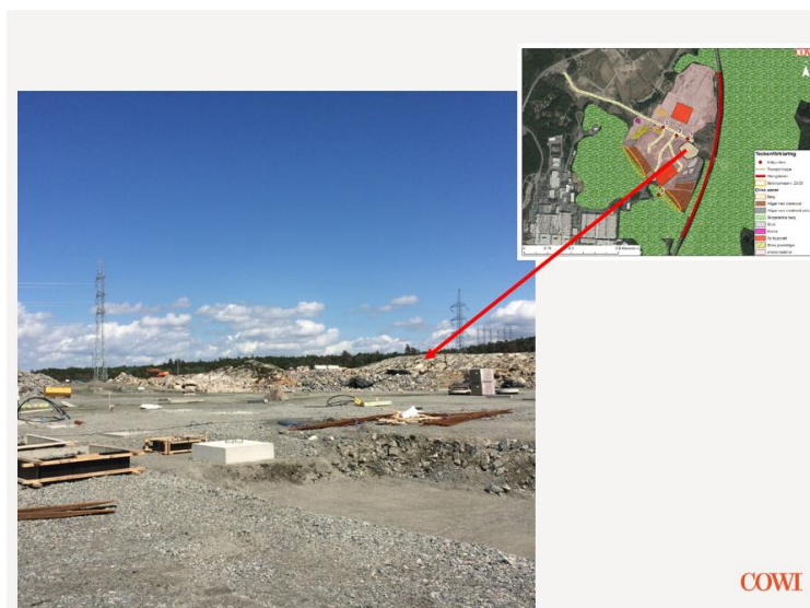
Figur 9. Detalj från byggarbetsplatsen.
