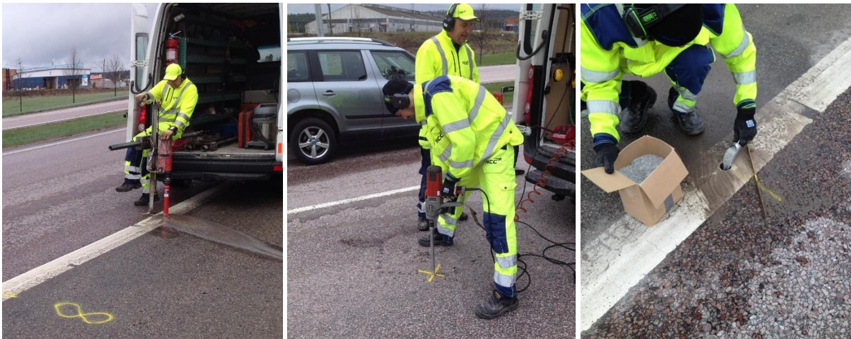
Figur 4 Borring av hål samt ifyllnad av stensmjöl.
