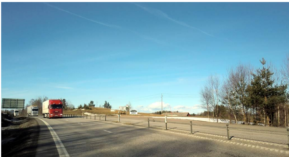
Figur 30: Väg 50 vid byn Ryggsten norr om Motala. Liten öppning i mitträcket för korsande gående. Mars 2011. (Foto: Jonna Nyberg, Inger Forsberg, VTI)
