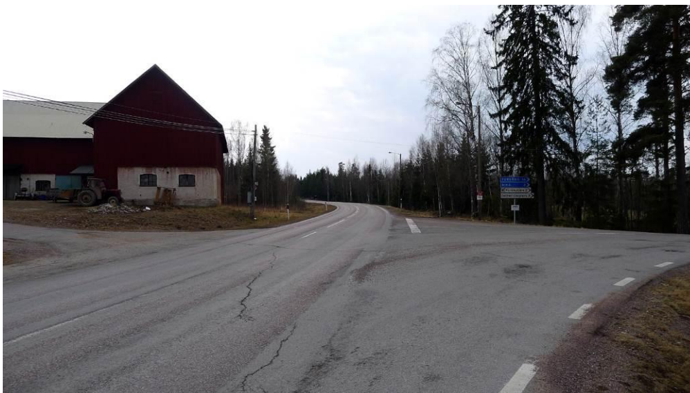
Figur 14: Korsning väg 266/väg 800 (mot Vika), bild söderut. April 2011. (Foto: Mikael Spjut, Svante Berg, Ramböll Sverige AB)
