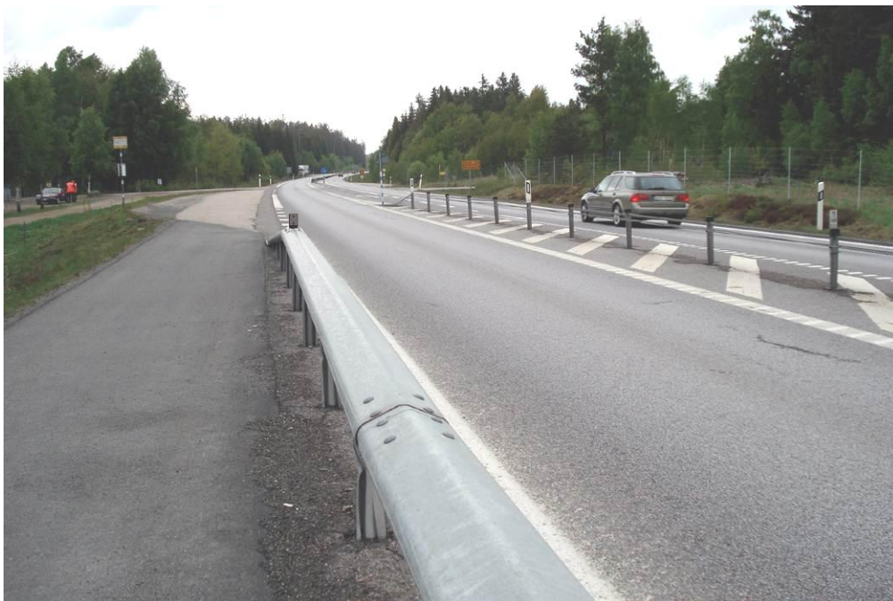
Figur 42: Cykelbanan vid väg 23 norr om Osby tar slut och fortsätter på andra sidan av vägen. Maj 2011. (Foto: Jutta Pauna, Ramböll Sverige AB)
