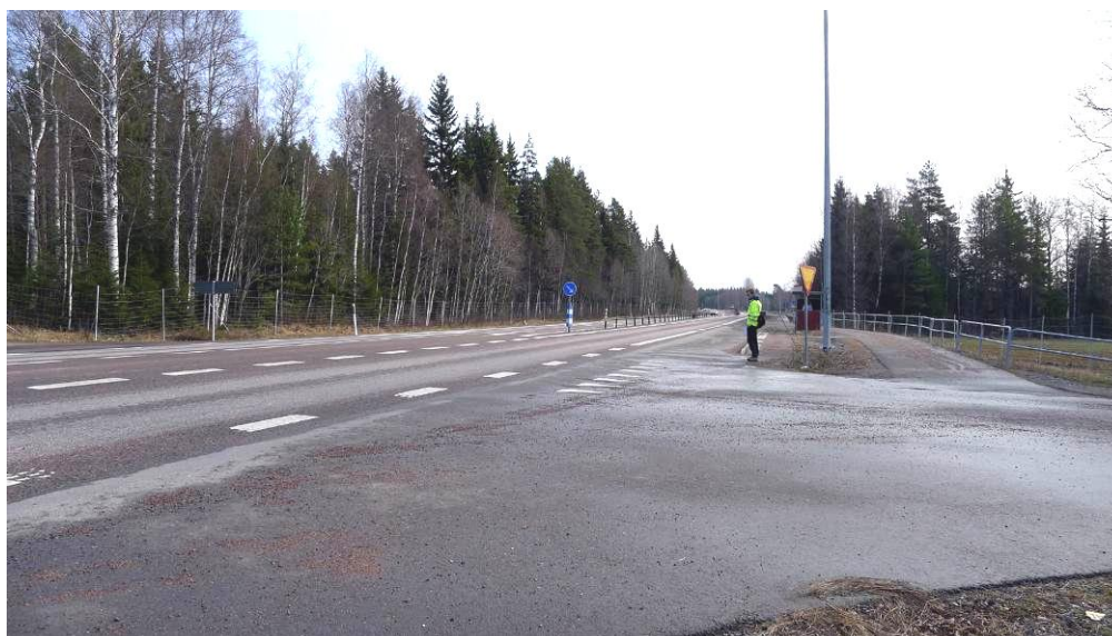
Figur 18: Väg 50 vid byn Lerbäcken söder om Borlänge. Busshållplats Trollebo. Cykelväg tar slut vid en busshållplats. April 2011. (Foto: Mikael Spjut, Svante Berg, Ramböll Sverige AB)
