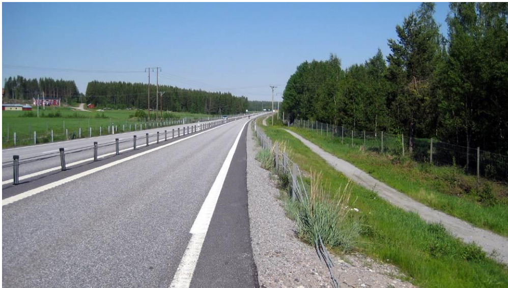
Figur 5: Cykelstig längs med E4 mellan Pitsund och Högländsnäs. Juni 2011. (Foto: Sebastian Arnehed, LTU)
