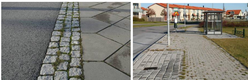
Figur 5-1 Olika beläggningmaterial ger skador i beläggningen pga fler skarvar. All användning av plattor och marksten ökar behovet av drift och underhåll eftersom det lätt blir ojämnheter och växer ogräs i skarvarna.
