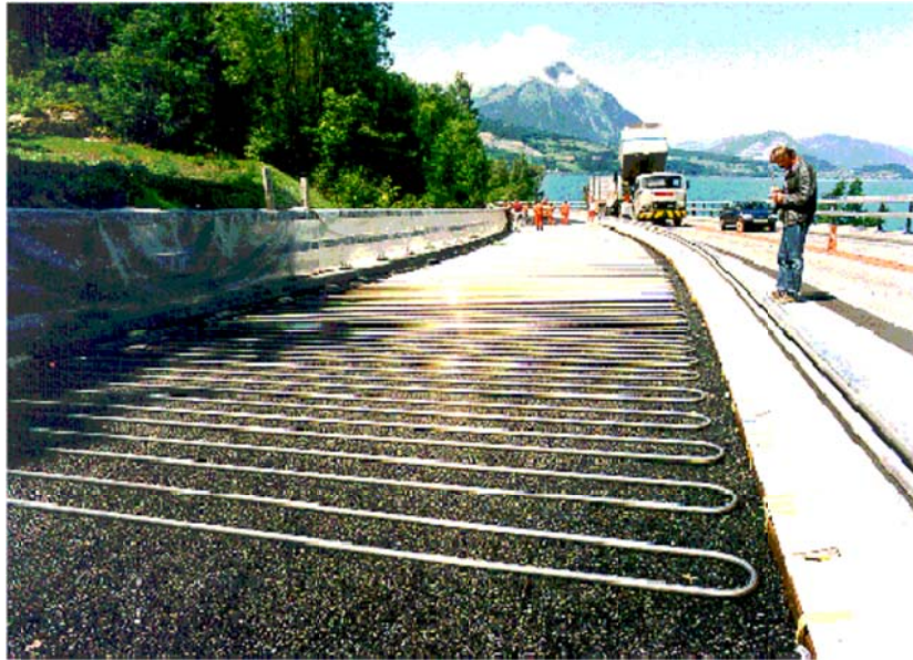
Figur 8. SERSO bron under byggnad.
