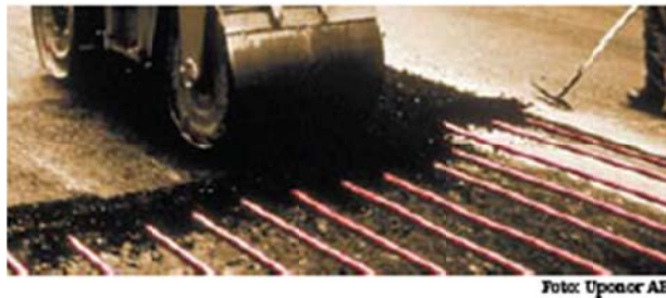
Figur 10. Asfaltering med synliga värmeslingor. Totalt installerades närmare 3 mil slingor (Trafikverket, 2006).
