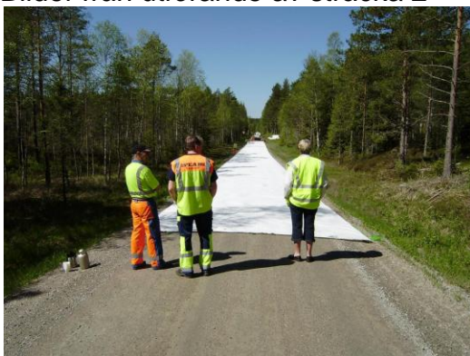
Geotextil läggs ut
